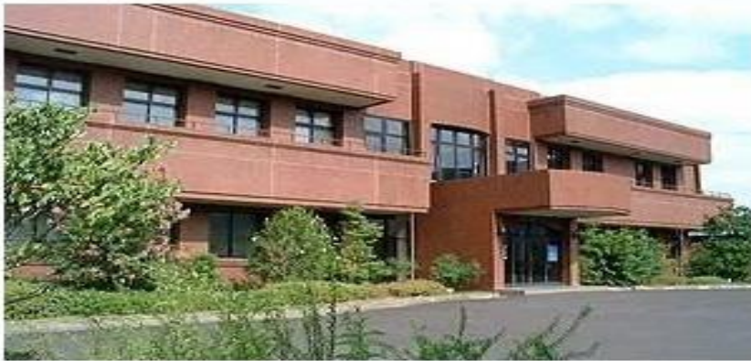
下水道処理浄化施設
